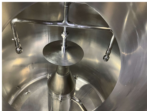
発酵タンクに取り付けられたSaniMidget
